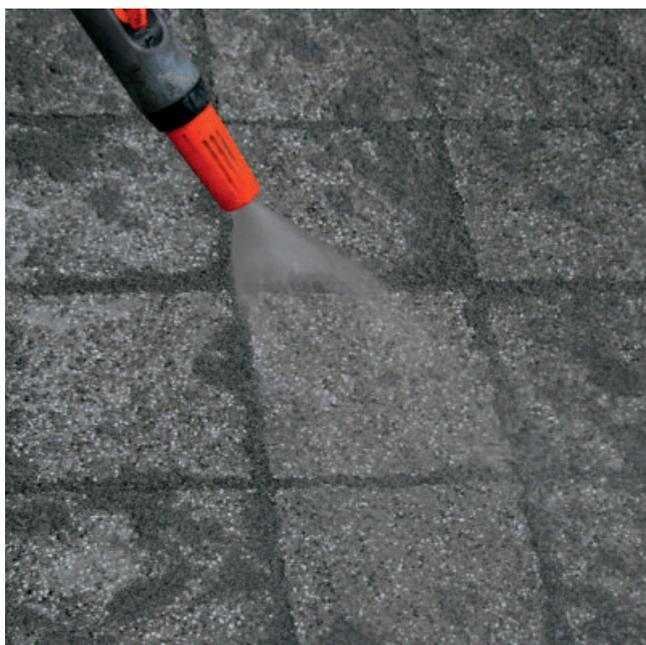
Bei Fugen von 3 - 8 mm das Einbringen in die Fugen mit dem Wasser-
