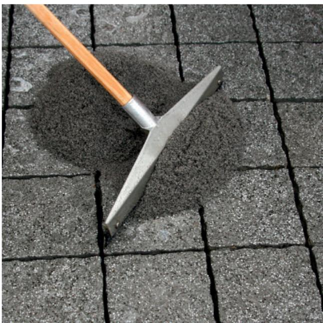
PCI Pavifix 1K Extra mit einem Gummischieber unter Druck in die Fugen
