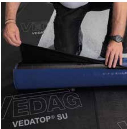
Bild 4: Unterseitenfolie lösen und umschlagen.
