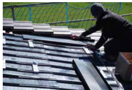
Bild 4: An den Seiten kommen Anschlussbleche zum Einsatz
