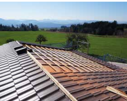
Bild 1: Das Dach ist bereits gedeckt. Nun ist alles bereit für die Installation der dachintegrierten PV-Anlage.
