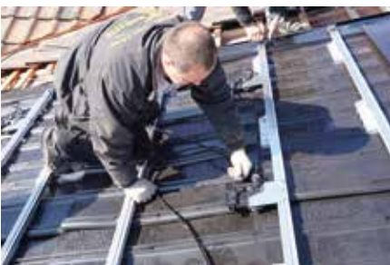
Bild 8: Das AC-Kabel wird eingeklipst.
