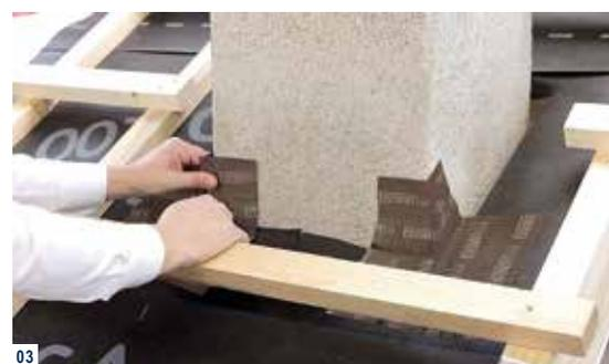
Schneller und leichter Einbau dank vorgefertigter Ecken.
