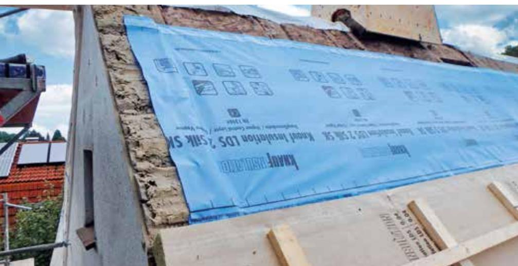
Für Dachsanierungen bereits ausgebauter Dachgeschosse von außen bietet Knauf Insulation mit dem Renovierungs-Dach KombiPlan eine Lösung, die nicht nur für beeindruckende Dämmleistungen sorgt, sondern auch Handwerkern das Leben leichter macht. Der Grund: Die Luftdichtheitsschicht kann einfach plan zwischen zwei Dämmschichten gelegt werden. Eine aufwendige Verlegung in die Gefache entfällt.
