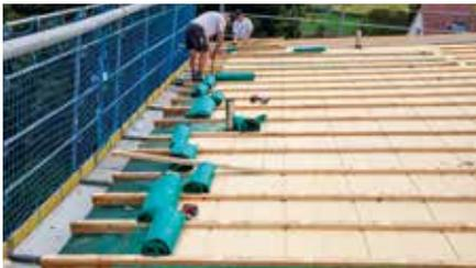
Für eine fachgerechte Neueindeckung mussten auch die alten Unterdachbahnen und die alte Konterlattung entfernt werden.
