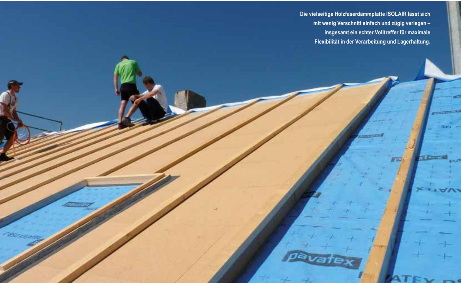
Die vielseitige Holzfaserdämmplatte ISOLAIR lässt sich mit wenig Verschnitt einfach und zügig verlegen – insgesamt ein echter Volltreffer für maximale Flexibilität in der Verarbeitung und Lagerhaltung.
