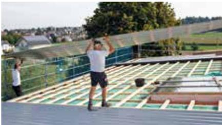
Wegen störender Geräuschentwicklung im Innenraum und einer undichten Stelle am Oberlicht musste die Aluminiumwelle abgedeckt werden.
