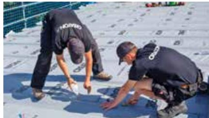
Auch die Konterlattenkappstreifen wurden mithilfe des Quellschweißmittels auf der Unterdachbahn verschweißt.
