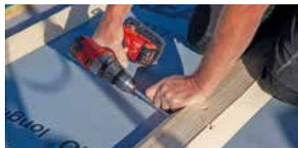
Bevor die Konterlatten mit Kappstreifen gesichert werden konnten, wurden an diese Dreikantleisten angebracht.
