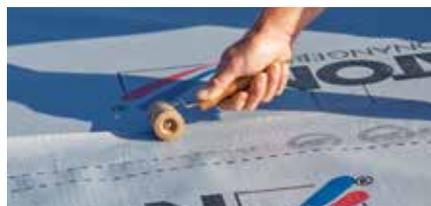
Anschließend wurden die Schweißnähte mit einer Andrückrolle angepresst.
