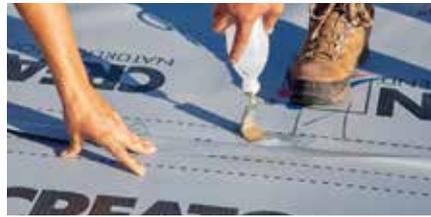
Mit einer Pinselflasche trugen die Fachhandwerker das Quellschweißmittel QSM im Längsnahtbereich der Unterdachbahnen auf.
