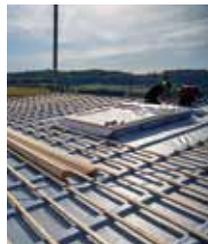
Nach Montage der Traglattung konnte mit der finalen Arbeit – der Verlegung der Dachziegel begonnen werden.
