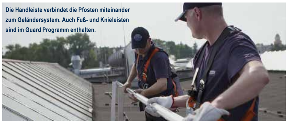
Aufstellen der vormontierten Pfosten gemäß Installationsplan.
