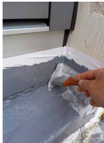
Die Verarbeitung ist einfach. Nach einem satten Voranstrich wird das zugeschnittene Vlies eingelegt und wieder überstrichen.
