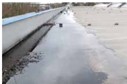
Kein seltener Anblick für Dachdecker: Stehendes Wasser aufgrund von verstopften Dachabläufen kann bei Starkregen oder Hagel die Abdichtung eines Flachdaches beschädigen und zu Wassereintrüben führen.
