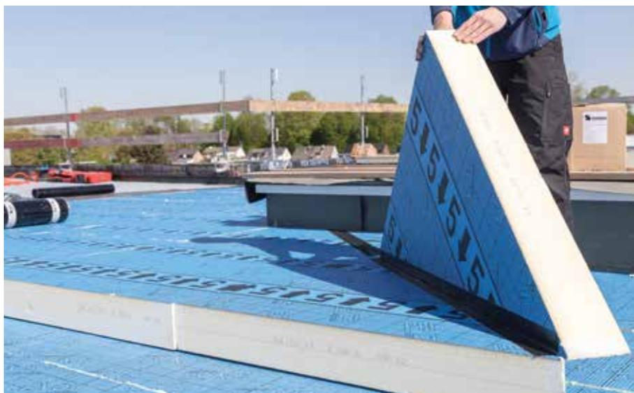
So muss ein modernes PIR-Gefälledämmsystem sein: Hochwertig, mit leistungsstarken Dämmplatten, die flache Aufbauhöhen ermöglichen, hoch druckfest, mit niedrigem Gewicht. Dazu flexibel einsetzbar und anwenderfreundlich.
