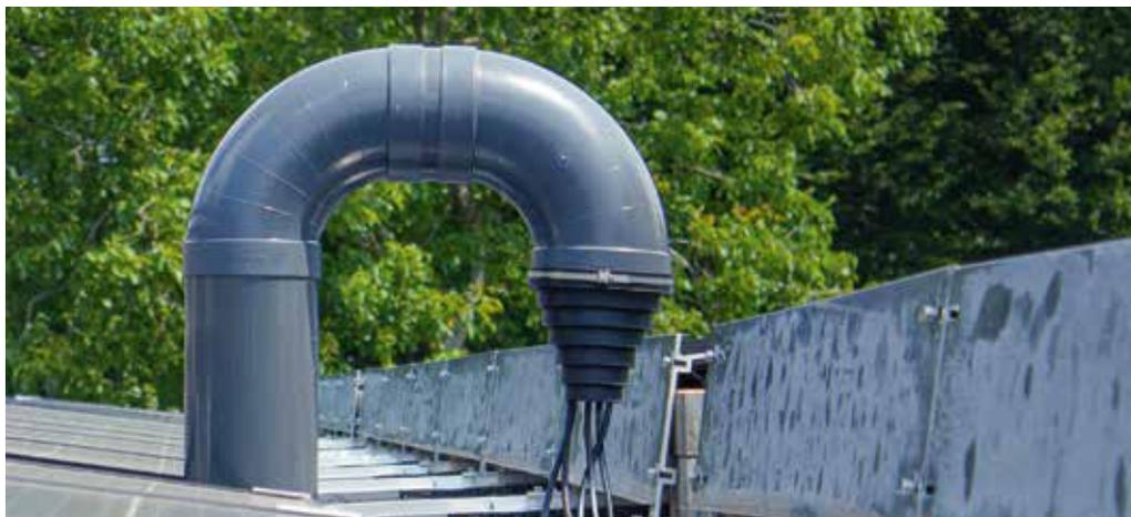
Die Durchgänge der FLECK-Schwanenhälse können einfach mit den Schwanenhals-Verschlussmanschetten verjüngt werden, um z. B. Kabel einer PV-Anlage sicher in das Gebäudeinnere zu verlegen.
