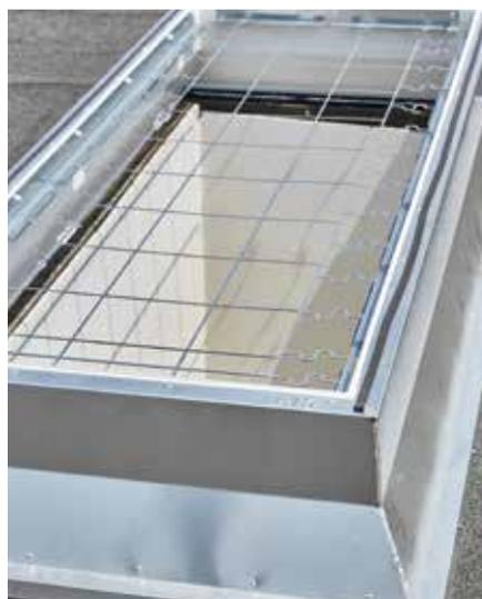
Mit der Ab- und Durchsturzsicherung entschied man sich für ein geprüftes und zertifiziertes System, das die Primärforderung der Arbeitsschutzrichtlinie A2.1 erfüllt und dauerhafte Sicherheit bietet.
