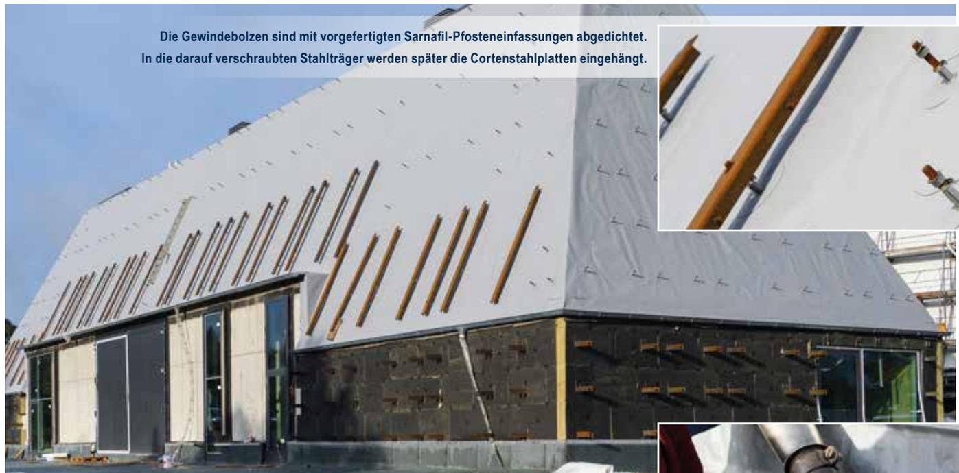
Die Gewindebolzen sind mit vorgefertigten Sarnafil-Pfosteneinfassungen abgedichtet. In die darauf verschraubten Stahlträger werden später die Cortenstahlplatten eingehängt.
