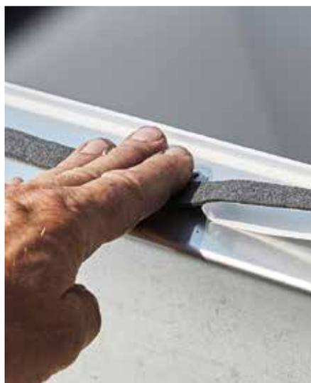
Der Montagerahmen und das Dichtungsset sorgen für eine sichere und passgenaue Verbindung an bestehende Aufsetzkränze aller gängigen Fabrikate, ohne einen Eingriff in die Dachbahn vornehmen zu müssen.
