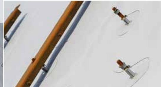
Die Scheundächer der neuen Museumsgebäude in Molfsee sind mit Sarnafil TS 77-15 E abgedichtet. Durch die Ausrüstung der Kunststoffbahnen und die Verwendung eines Glasvlieses wird ein hoher Brandwiderstand erzielt.
