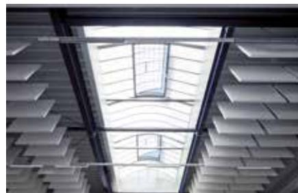
GRILLODUR® Lichtbänder sind durchsturz-sicher konstruiert. Die Klappenöffnungen können zusätzlich mit einer Durchsturz-sicherung ausgestattet werden, um maximale Sicherheit auf dem Dach zu gewährleisten.
