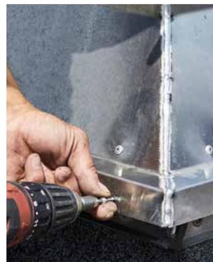
Die Sanierung wurde durch den Einbau des Aufstocksystems ASM wesentlich vereinfacht. Es besteht aus einem zweischaligen, isolierten und thermisch getrennten Aufstockelement mit systemseitigen Aufbauten.
