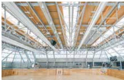
Im Sportzentrum Bertrange ermöglichen leichte GRILLODUR®-Tageslichtelemente mit Rauch- und Wärmeabzug eine lichtdurchflutete und sichere Sporthalle. (Foto: Peter Witt)
