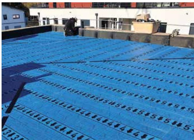
An der schwarzen Linie verlaufen gut sichtbar Kehle und Grat. Die Pfeile zeigen immer in Fließrichtung.
