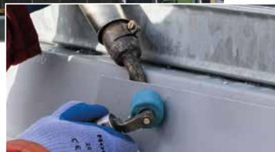
Die Dachneigung von 66 Grad und der enge Arbeitsraum erfordern eine manuelle Verschweißung der Sarnafil-Abdichtungsbahnen.
