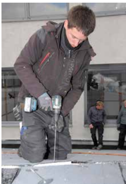
Bohren und Schrauben bis auf den Grund – hier Stahltrapezblech
