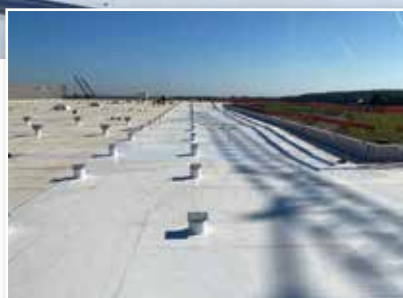
Auf dem Flachdach befindet sich die Lüftungstechnik für das Molkerei-Gebäude, die von einer Unterkonstruktion mit 900 Stützfüßen getragen wird. Die Dachdurchdringungen wurden mit Sondereinfassungen abgedichtet.
