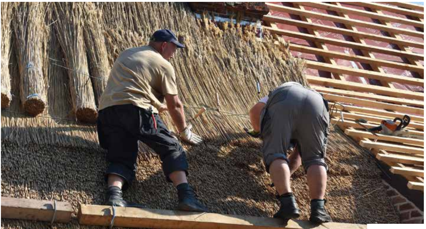
Das Reet wurde Schicht für Schicht von der Traufe bis zum First verlegt und fixiert. Als nachwachsender Dachwerkstoff hat Reet eine extrem positive CO 2 Bilanz, einen kaum zu übertreffenden Strahlungswärmschutz und einen enormen Wohlfühlcharakter.
