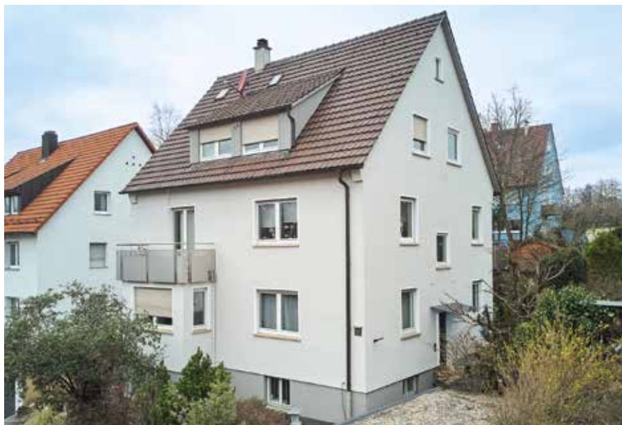
Das Objekt nach der Sanierung – ökologisch und gerüstet für die Zukunft
