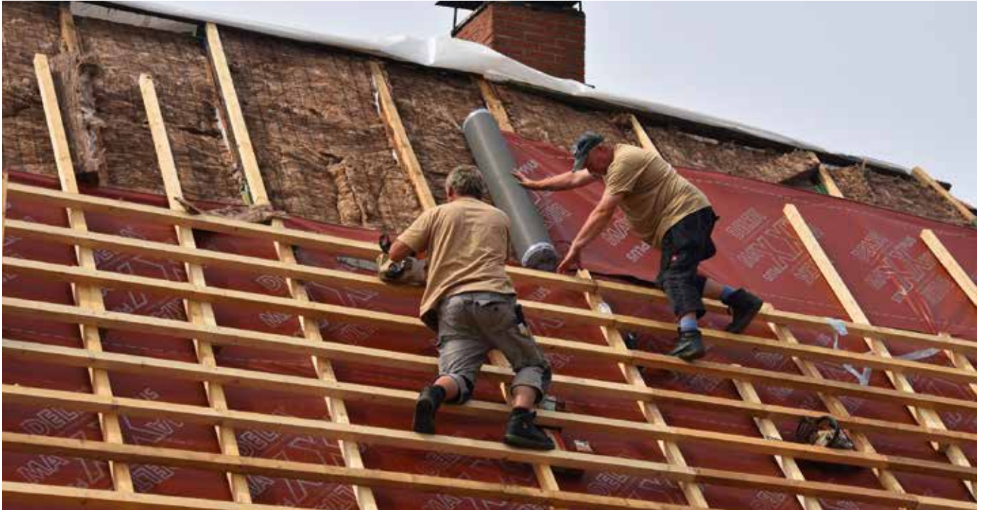
Die extrem reißfeste Delta-Maxx Plus wurde als Unterdeckbahn verlegt. Das Material bietet langfristig Schutz vor Feuchtigkeit und lässt sich wirtschaftlich und effizient verarbeiten.
