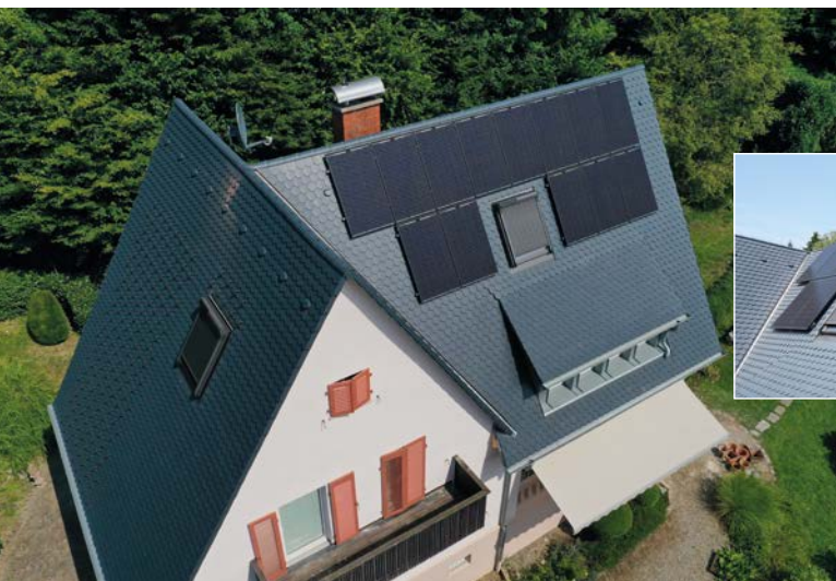
Aufdach-PV Anlage passt sich flexibel den Gegebenheiten auf dem Dach an
