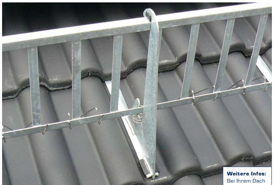
Systemergänzung: verstärkter Schneefang mit Universal-Einhängesystem
