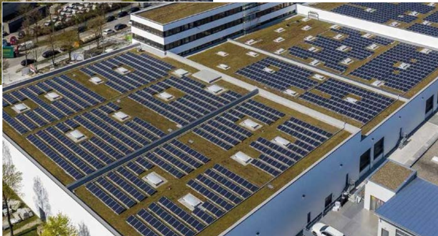
Optimal geeignet ist das Sarnafil-System bei Dachbegrünungen sowie der Montage einer Photovoltaikanlage wie hier auf dem Centro Tesoro in München. (Foto: Schwaiger Group GmbH)
