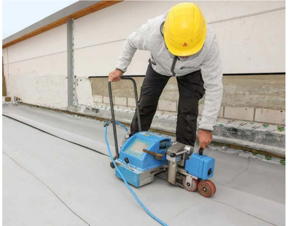
Mit dem Sarnamatic-Automaten heißluftverschweißt, lassen sich Überlappungen von Bahnen wasserdicht verbinden
