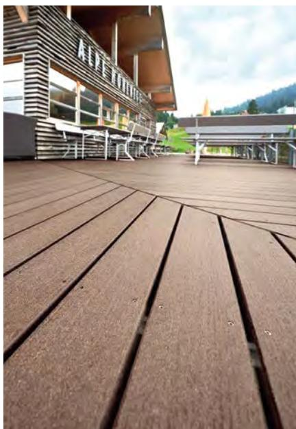
Der neue Belag aus pflegeleichtem und strapazierfähigem Holzverbundwerkstoff garantiert Langlebigkeit sowie Sicherheit aufgrund seiner rutschhemmenden Eigenschaften – auch bei nasser Witterung wie Nebel, Regen oder Schnee
