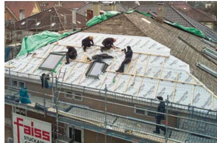
Das Abziehen der Schutzfolie von beiden Längsnähten und das Andrücken der Klebeflächen geschieht in einem einzigen Arbeitsgang
