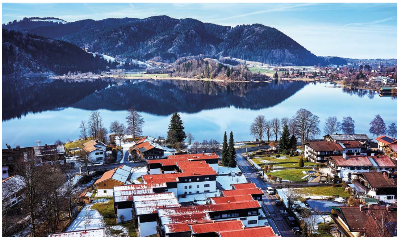
Wohnanlage Oberland, Schliersee
