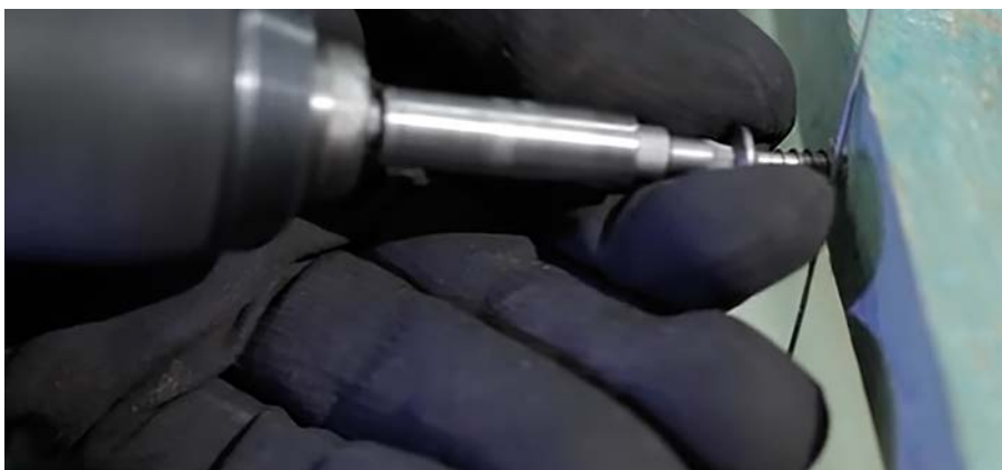
4. Eine korrosionsgeschützte Schraube wird nahe der Pfanne an der Dachkonstruktion angebracht, aber nicht komplett eingeschraubt.
