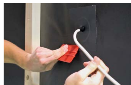
Einfacher Einbau der selbstklebenden Luftdichtungsmanschette
