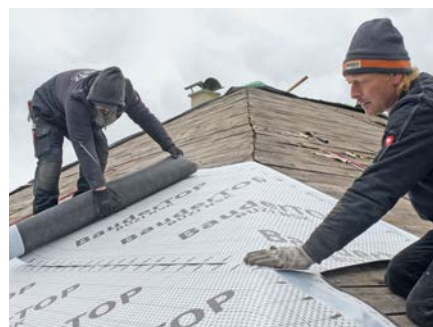
Von der Traufe ging es nach oben – Bahn für Bahn
