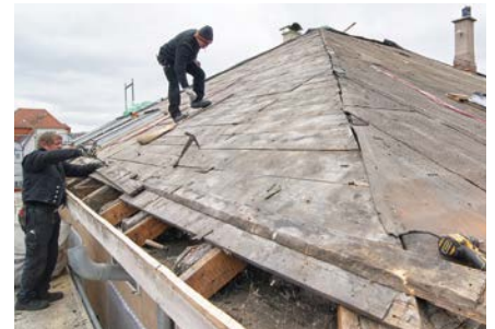
Abriss der alten Bedachung
