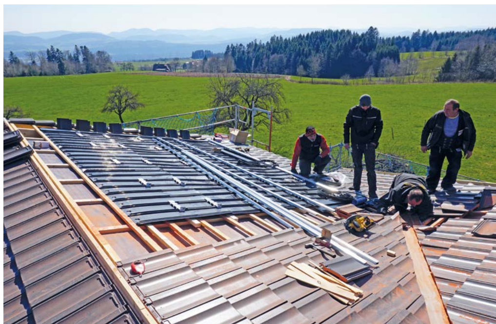
Nachdem die Anker gesetzt wurden, können die Schienen montiert werden
