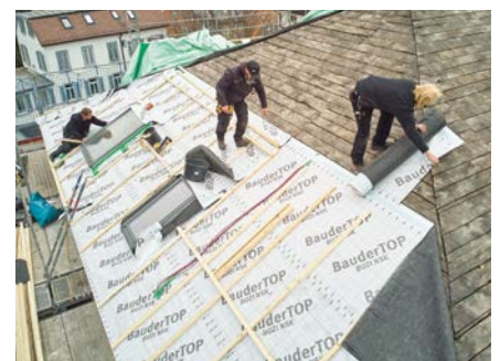
Die Verlegung: schnell, wirtschaftlich und effizient
