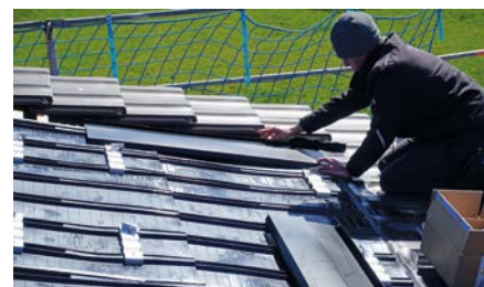
An den Seiten kommen Anschlussbleche zum Einsatz
