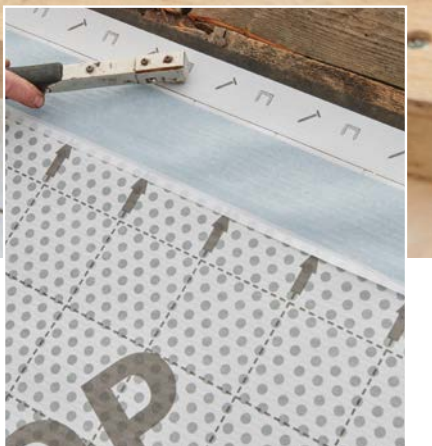
Das Abziehen der Schutzfolie von beiden Längsnähten und das Andrücken der Klebeflächen geschieht in einem einzigen Arbeitsgang
