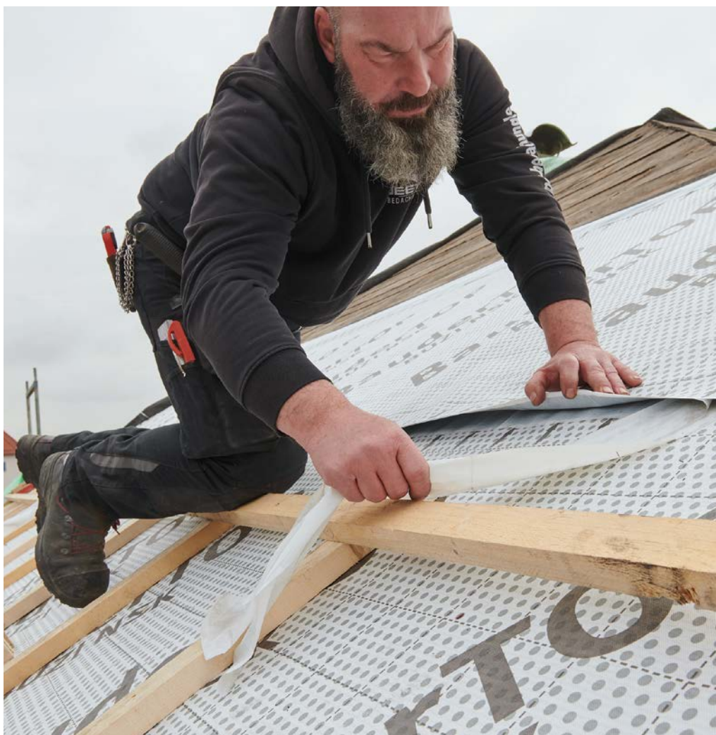
BauderTOP BUZI NSK - die diffusionsoffene und nahtselbstklebende Bitumen-Unterdeckbahn
