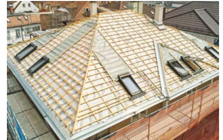
Die endgültige Befestigung erfolgte mittels Konterlattung, an der Traglattung werden die neuen Ziegel eingehängt
