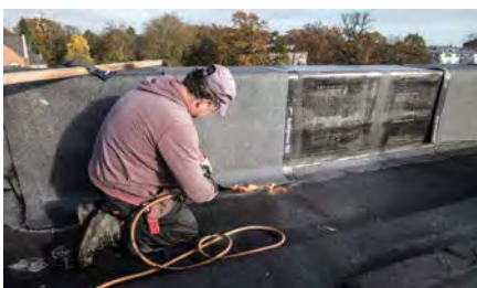
Aufschweißen der Oberlagsbahn „Kubigreen WS“, FLL-geprüfte Wurzelschutzlage
