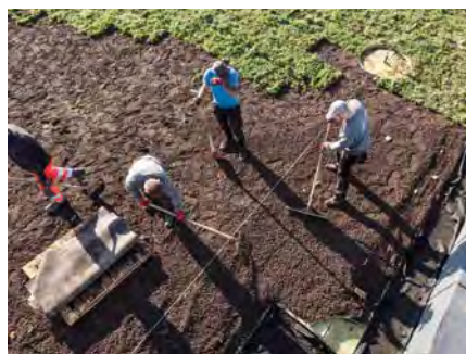
3. Aufbringen von 30 mm „Hasse Extensivsubstrat“
