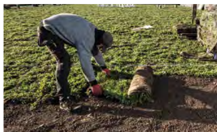
4. Verlegung der „Hasse Vegetationsmatten Sedum-Kräuter“
