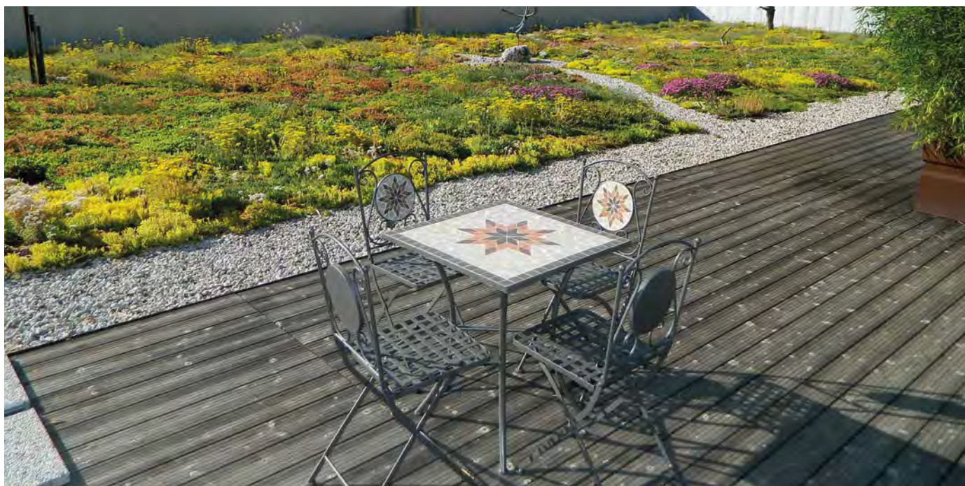
Extensive Dachbegrünung auf einem Industriedach
