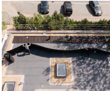
1. Verlegung der Drainageschicht „Hasse Kombidrain 17“
