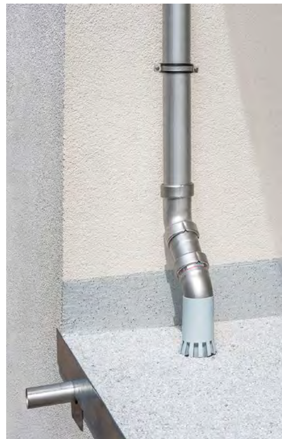
Der geschlitzte Strahlenkranz der Fallrohraufnahme ermöglicht auch den seitlichen Zufluss von Regenwasser
