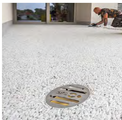
Repräsentativ und zu Wartungszwecken abnehmbar: Der Flachrost aus gebürstetem Edelstahl
