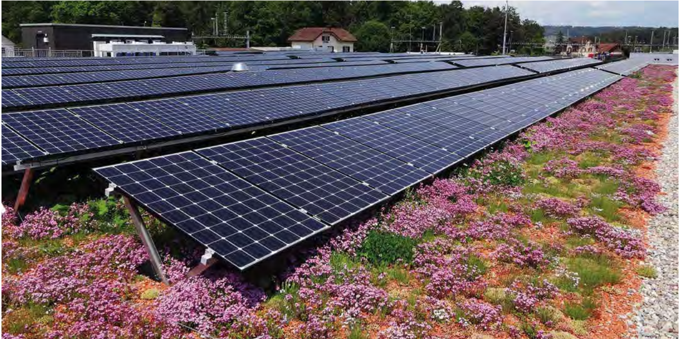
Photovoltaik und extensive Dachbegrünung – eine sinnvolle Kombination
