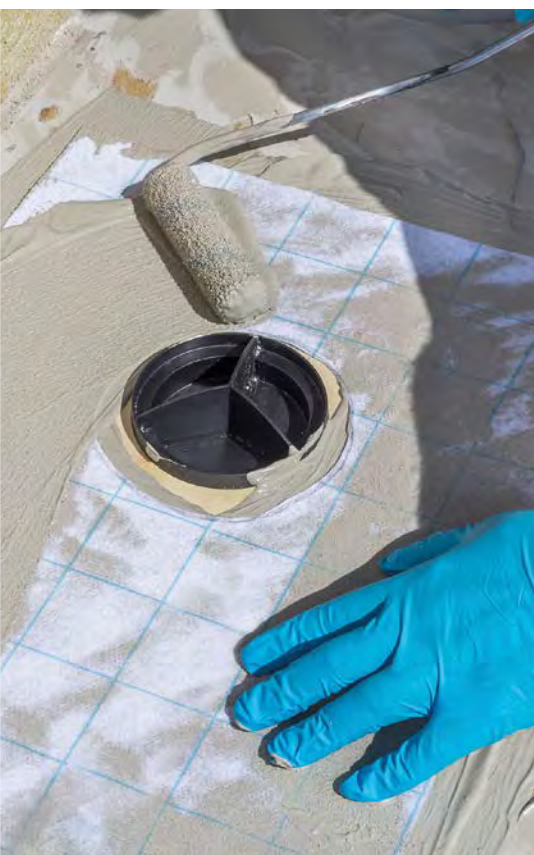
Rundum-Schutz: Der mitgelieferte PE-Schutzdeckel hält den Ablaufkörper während des Auftragens der einzelnen Kunststoffschichten sauber
