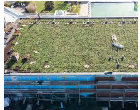
Innerhalb kurzer Zeit wurde durch das Dachdeckerun-ternehmen eine sofort funktionierende und abnahme-fähige Begrünung auf der Dachfläche hergestellt
