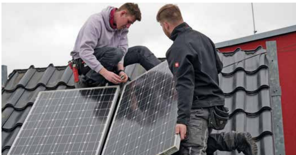
Eslohe – Arbeiten an einer PV-Anlage
