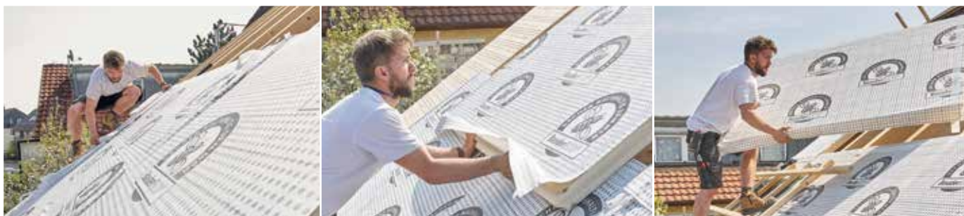
Verlegung von BauderECO als Aufsparrendämmung
