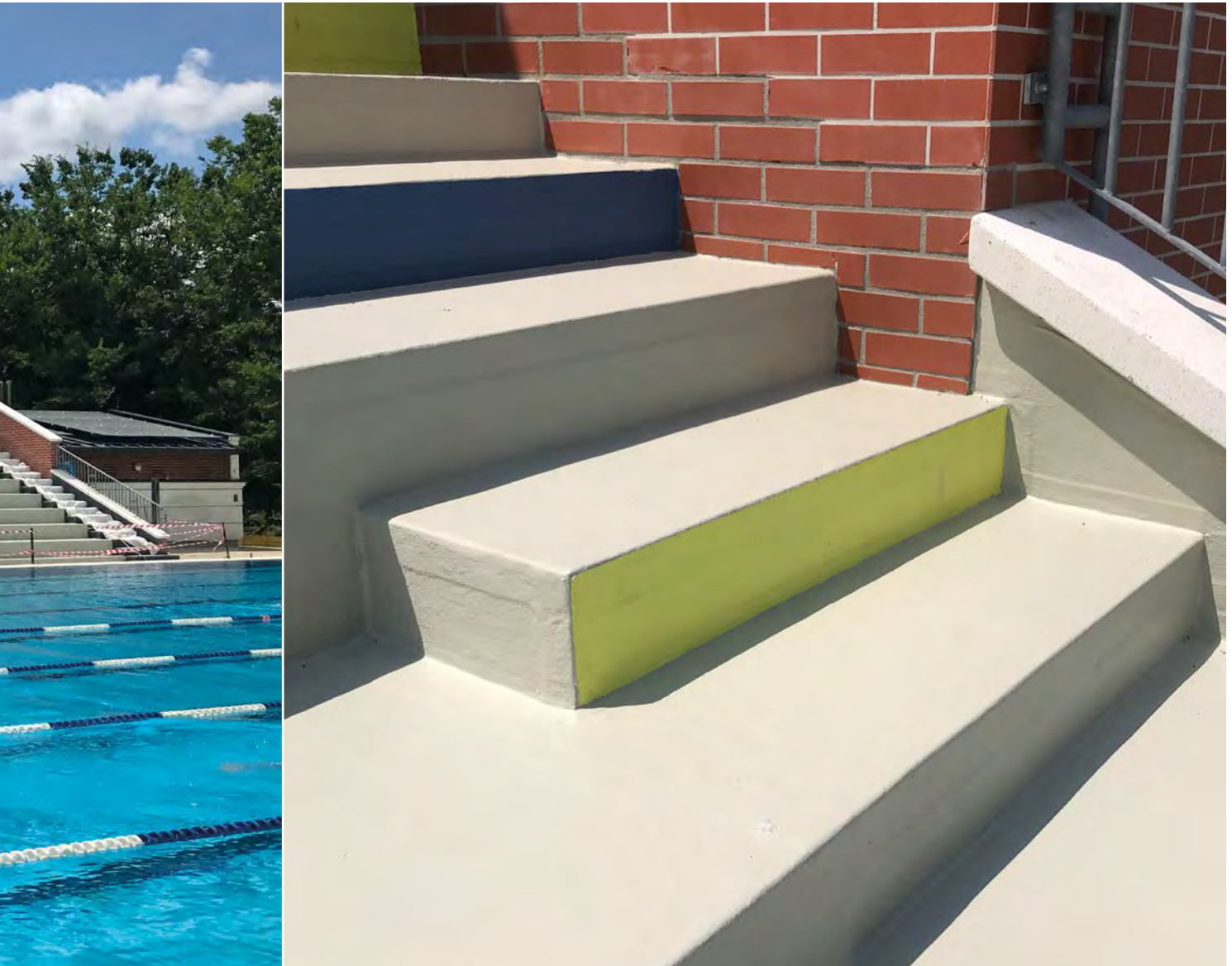
Abdichtungs- und Beschichtungsarbeiten Tribüne
