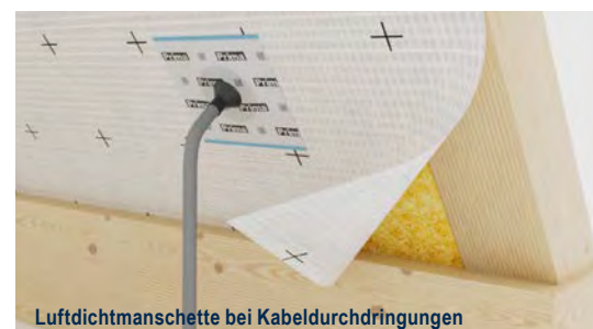
Luftdichtmanschette bei Kabeldurchdringungen
