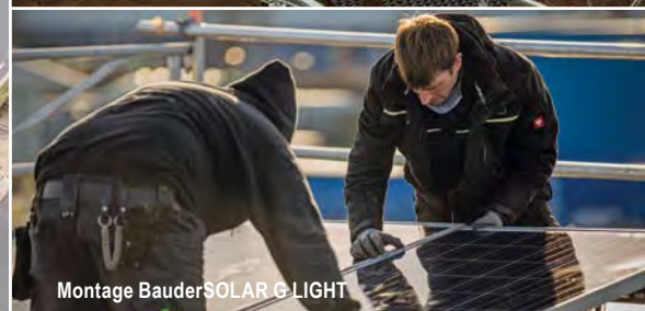
Montage BauderSOLAR G LIGHT
