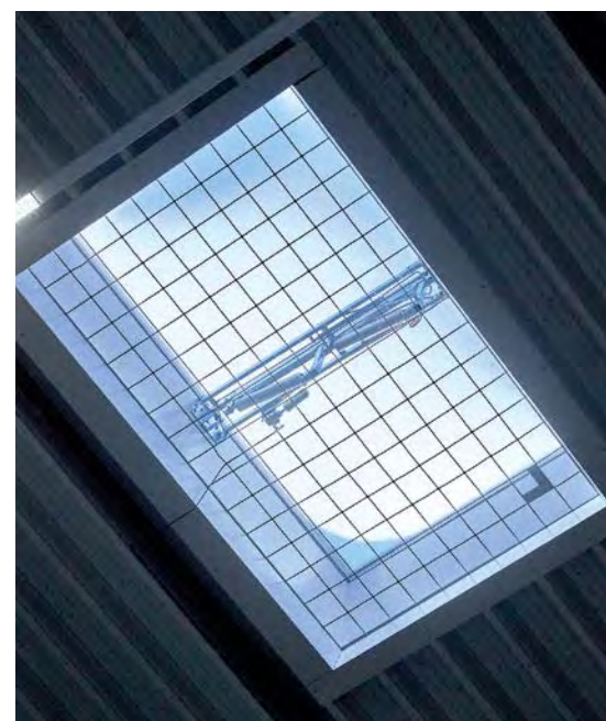
Die Auffangsicherungen vom Typ LK-L sowie LK-K ermöglichen einen dauerhaften und verlässlichen Schutz vor Unfällen an Lichtkuppeln
