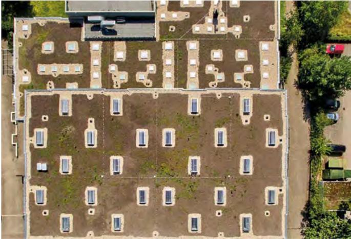
Das Dach der Sportstätte wurde neu gedämmt sowie abgedichtet und mit einer extensiven Dachbegrünung versehen. Für die natürliche Belichtung der großen Halle sowie der Nebenräume wurden neue und effizientere Oberlichter verbaut.
