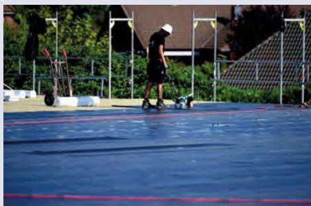
**Präzisionsarbeit: Längsnahverschweißung mit dem Schweißautomaten**
