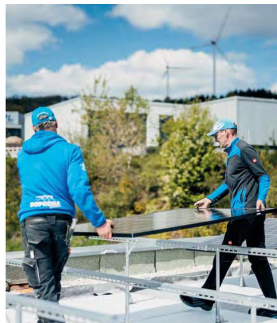
Für die Kombination mit Gründächern bietet Flachdachexperte SOPREMA die aufgeständerte PV-Unterkonstruktion SOLAR Nature an, bei der das Substrat als Ballastierung dient. Mit dieser Konstruktion haben die Pflanzen unter den Modulen genug Licht und verschatten diese nicht. Einmal gut geplant, ist das System einfach und schnell montiert.
