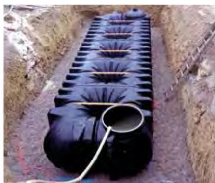
Der GRAF Platin Flachtank wurde mit dem LKW von Yves Kessler transportiert und mit dem Bagger in die Baugrube versetzt
