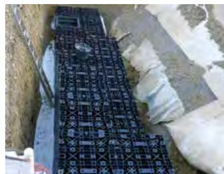
Die Versickerungsanlage wurde vom Team von Yves Kessler vor Ort aus 60 Rigolenkörpern EcoBloc 420 erstellt
