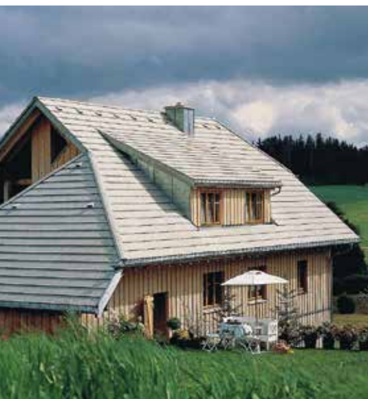
Krüppelwalmdach mit Anbau mit Glattziegeleindeckung und Wandverkleidung aus Boden-/Deckelschalung
