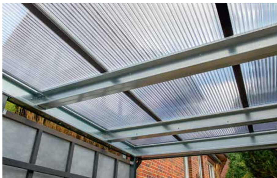
Die robusten Polycarbonat-Stegplatten Marlon Premium bieten garantierte Hagelsicherheit und eine lange Lebensdauer. Der große Kammerabstand sorgt für eine blendfreie Helligkeit des überdachten Objektes
