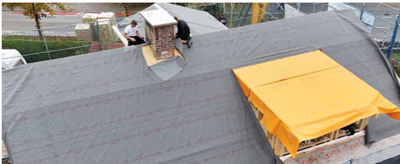
Das Dach innert Minuten statt Stunden verlegt mit der Ampatop®Protecta 3D-Vorkonfektion von Ampack
