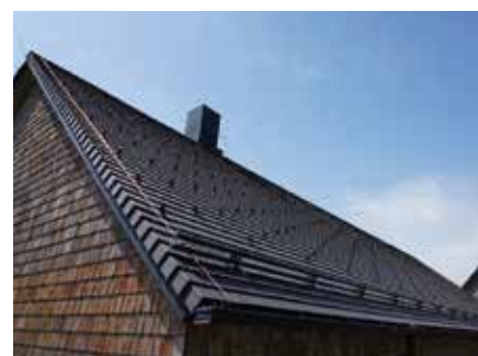
Referenzobjekt mit Biber Geradschnitt in Anthrazit und dem Zubehör Schneestopper und Schneefang
