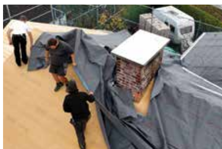
3D-Elemente inkl. der richtigen Verklebung
