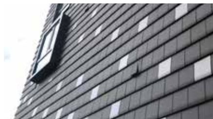
Tradition trifft Moderne: Die Fassaden in Camden Town wurden mit Edilians HP 10 Huguenot in lebendigem Farbmuster eingedeckt und mit der Seitenfalzklammer 409-207 von FOS befestigt
