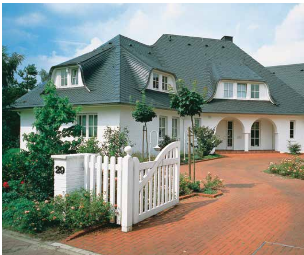
Walmdach mit Schiefer in „Deutscher Deckung“ eingedeckt
