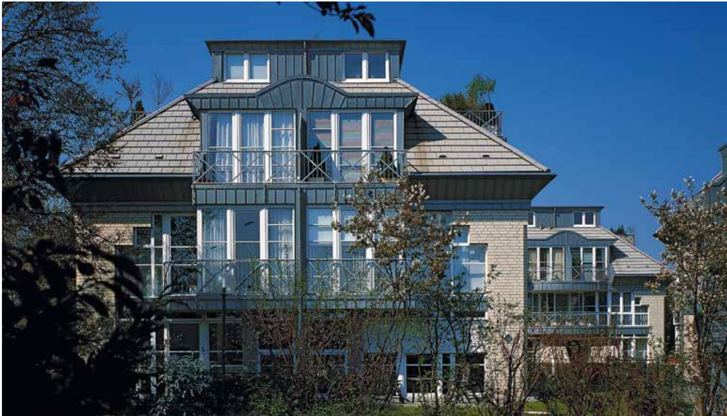
Walmdach mit Glattziegeleindeckung
