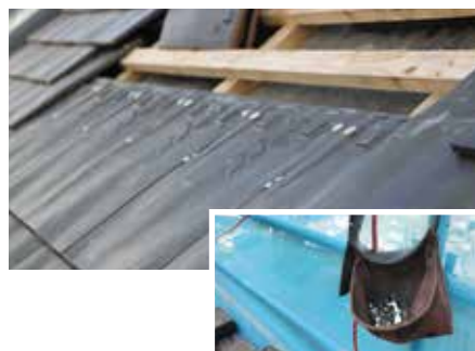
Fassadenlösung mit System: Die Biberschwanzklammer 425-031 von FOS sichert den Edilians Stretto auf der Dachfläche des Bauabschnitts Knightbridge zuverlässig gegen Windsog.
