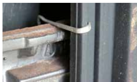
Geprüft und bewährt: Die Seitenfalzklammer 409-207 von FOS für den Edilians HP 10 erfüllt alle Anforderungen an Abhebewiderstand, Qualität und Montagefreundlichkeit
