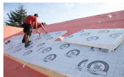
Verlegung der Aufsparrendämmung BauderECO S
