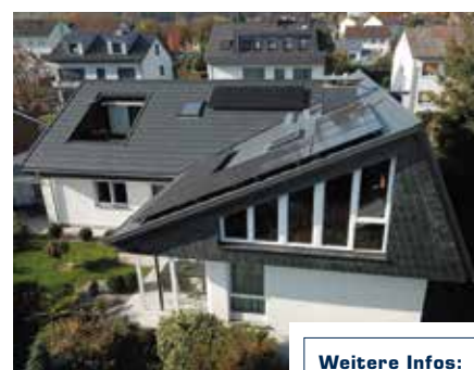
Erfolgreiche Dachsanierung in Butzbach
