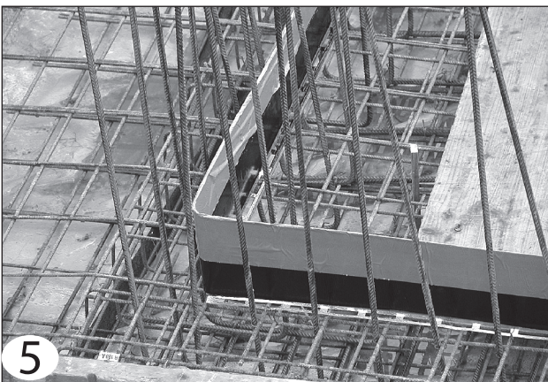
Befestigung mittels Bindedraht an der Halteschiene. Im Eckbereich einfach abbiegen
