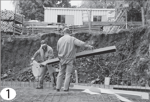
Entfernen der unteren Schutzfolie
