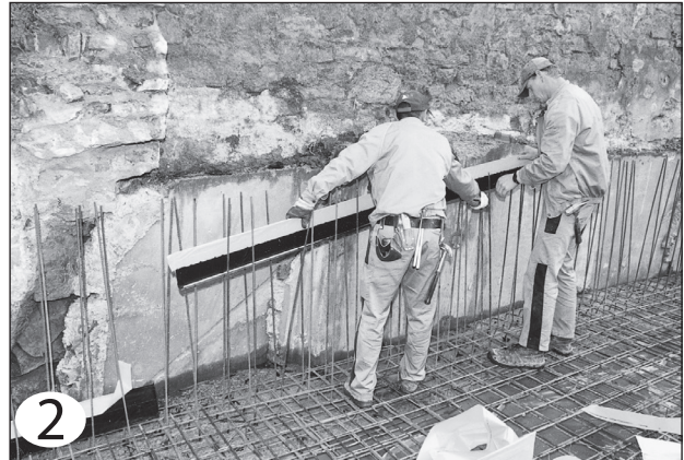
Aufstellen des Elementes auf die oberste Armierungslage
