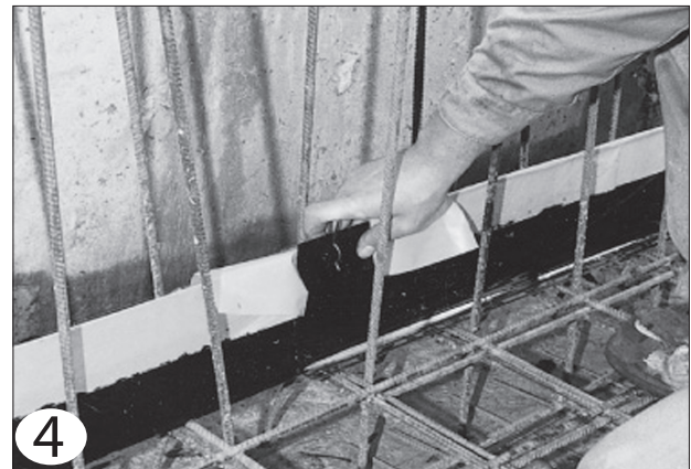
Sicherung der Verbindungsstelle durch eine Stoßklammer
