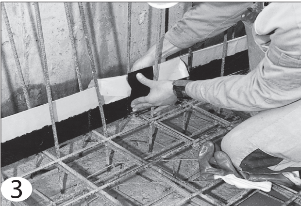
MASTER-Dichtblech 7 cm überlappen und gegeneinander pressen
