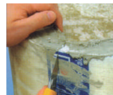
Einfaches und schnelles Ausschalen mit Hilfe eines Messers.
